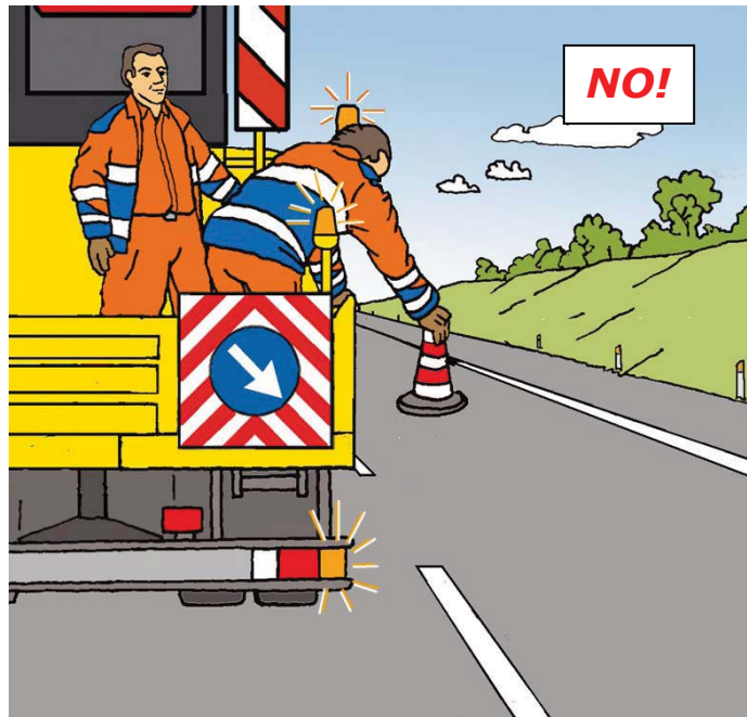
Figura 60 – Posizionamento dei coni o defleco: comportamento scorretto
