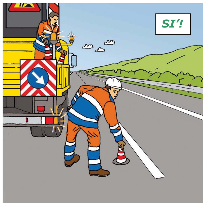
Figura 59 – Posizionamento dei coni o defleco: comportamento corretto
